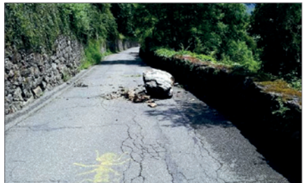
Chute de rochers, montée St Sébastien
