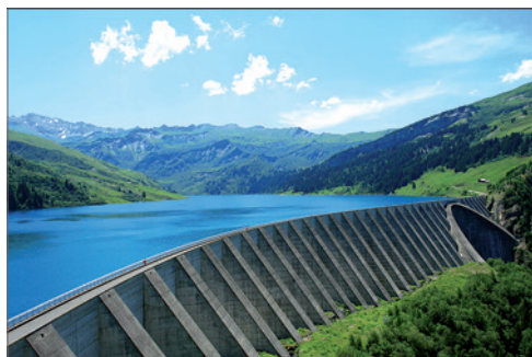
Le barrage de Roselend
