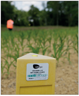
Borne matérialisant le passage de la conduite
