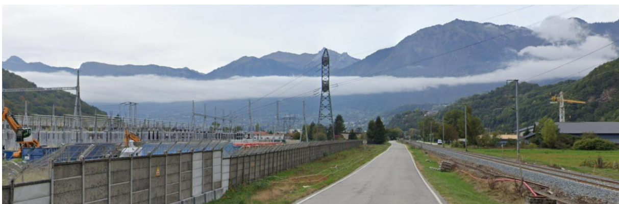
Emplacement réservé délimité entre la chaussée et le mur de clôture de l'emprise EDF
