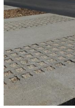
Béton alvéolaire avec un remplissage gravillonné
