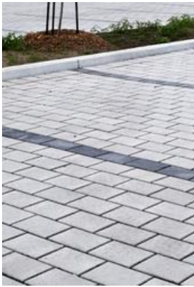
Les pavés drainants
