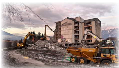
Démolition du bloc 3 de la Contamine
