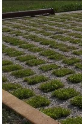
Béton alvéolaire avec un remplissage végétalisé
