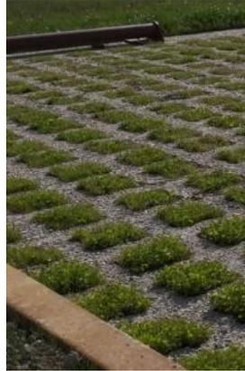
Béton alvéolaire avec un remplissage végétalisé
