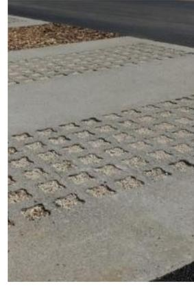
Béton alvéolaire avec un remplissage gravillonné
