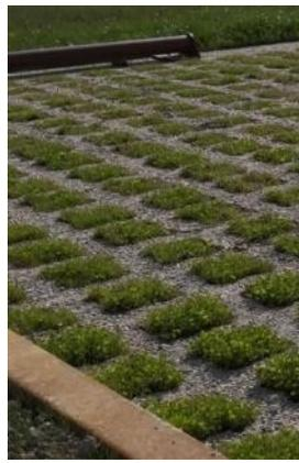
Béton alvéolaire avec un remplissage végétalisé
