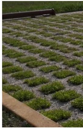
Béton alvéolaire avec un remplissage végétalisé
