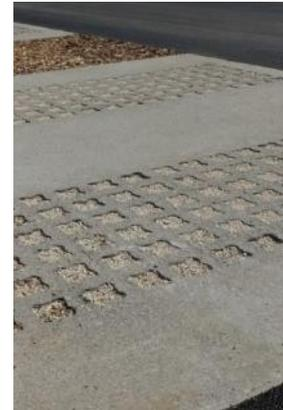
Béton alvéolaire avec un remplissage gravillonné
