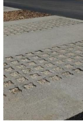
Béton alvéolaire avec un remplissage gravillonné
