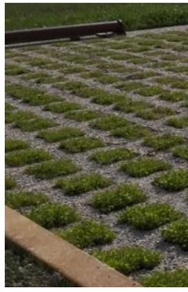
Béton alvéolaire avec un remplissage végétalisé
