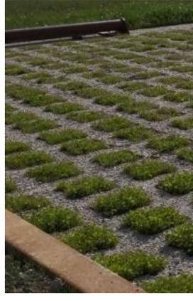
Béton alvéolaire avec un remplissage végétalisé
