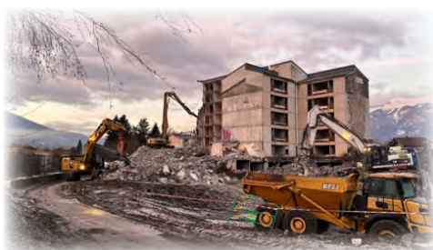
Démolition du bloc 3 de la Contamine
