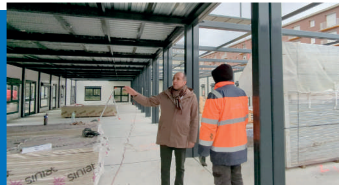
Monsieur le Maire Métin YAVUZ sur le chantier de la nouvelle école maternelle Paul Éluard, vendredi 31 mars dernier.
