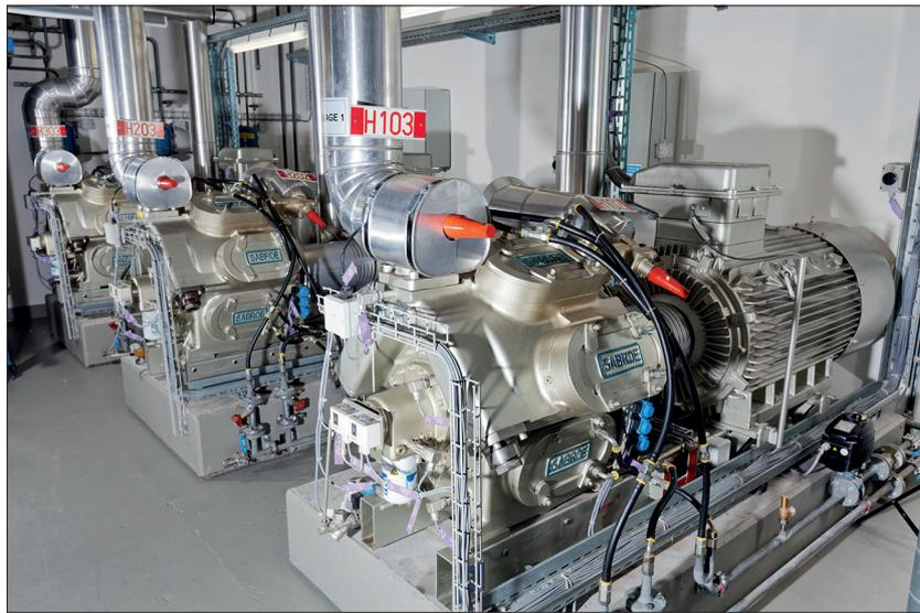
Bild 4. Die Geothermiewärmepumpen in der Grundlastzentrale in Riehen
