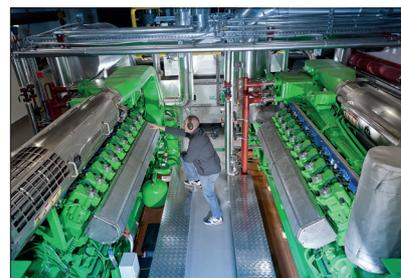
Bild 5. Gas-Blockheizkraftwerke als Wärmequellen und Stromerzeuger
