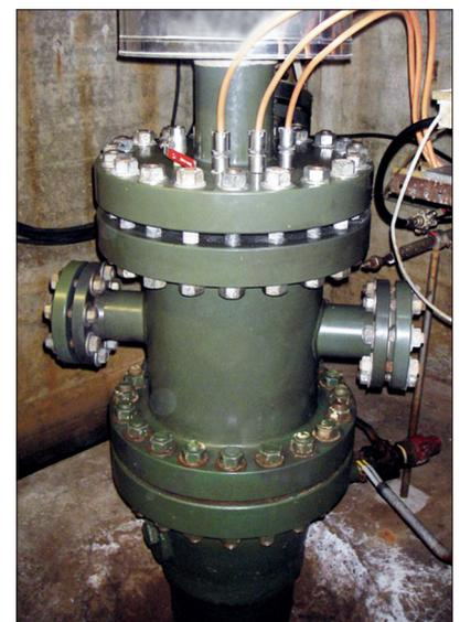
Bild 2. Brunnenkopf des Entnahmekopfbrunnens; hier wird das Thermalwasser mit einer Tauchpumpe aus etwa 1 500 m Tiefe gefördert
