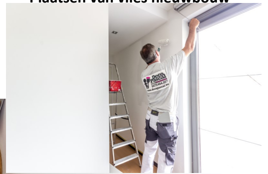
Plaatsen van vlies nieuwbouw
