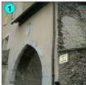
1 La Porte de Savoie - XIVe Ouverte sur fenestration du XIVe siècle, la porte commandait l'entrée de la ville du côté du comté de Savoie. ISMH 8/09/1928
